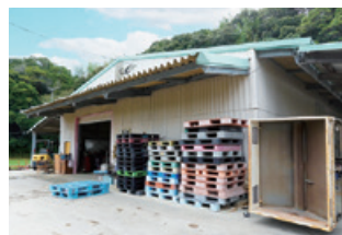
大きな倉庫を活用し、日々作業が進められています
